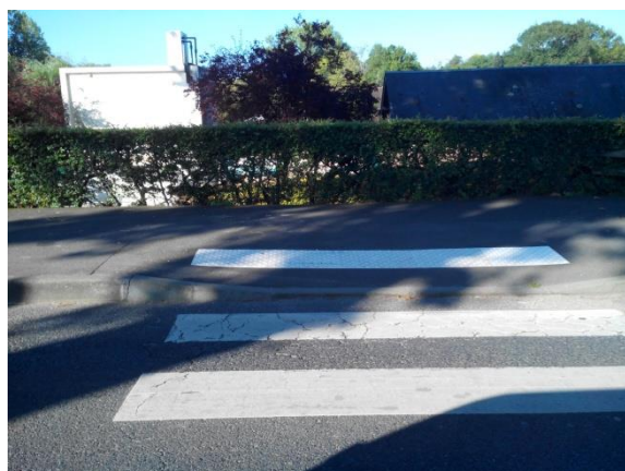
Réalisation des bandes podotactiles pour 10 passages pour piétons
