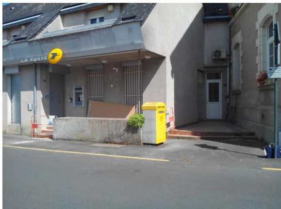
Locaux de La Poste avant travaux
